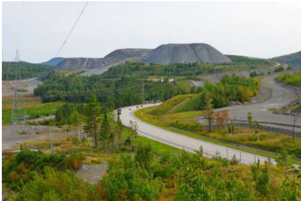
Photo 7 Certains pentes, notamment à proximité de la route 112 ont déjà été revégétalisés. Cependant, la majorité des talus demeure instable et vulnérable à l'érosion excessive.
