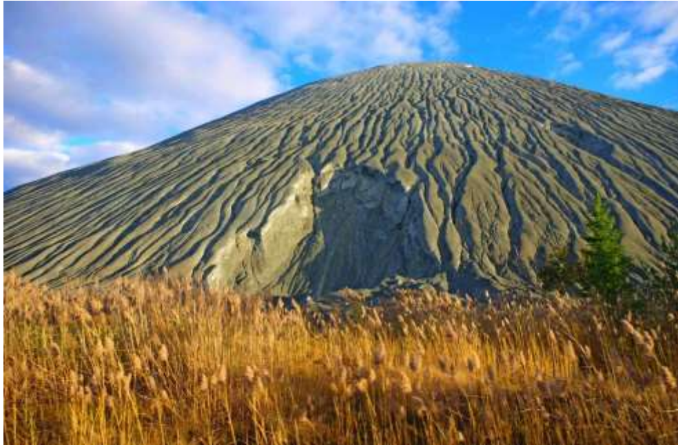
Photo 4 Les pentes des haldes sont soumises à des processus érosifs considérables, ce qui entraîne la formation de ravins. De plus, l'instabilité des pentes se manifeste par des ruptures multiples de la nature géotechnique.
