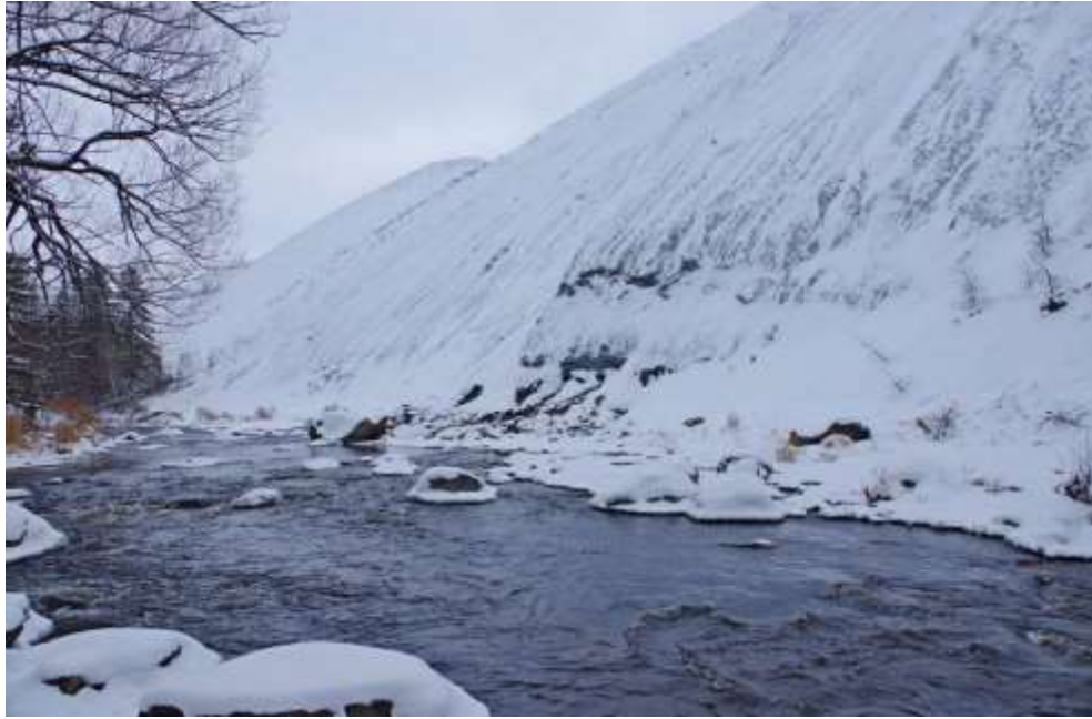
Photo 6 À quelques endroits, les haldes empiètent directement dans le cours d'eau. Les forces hydrodynamiques de la rivière sont responsables de l'érosion importante des talus.
